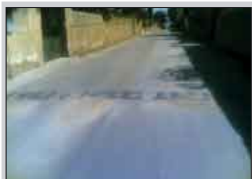
Rallentatori, in contrada Montagna, i quali a causa dei pezzi mancanti rischiano di essere più pericolosi che se non ci fossero
